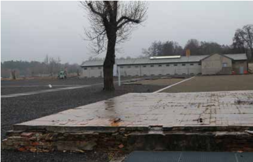
Abb. 2 Bodenplatte der Eingangsbaracke für medizinische Untersuchungen, Duschen usw., im Hintergrund der „Bunker“ (Zellenbau), 2019 Foto U. Kasten
