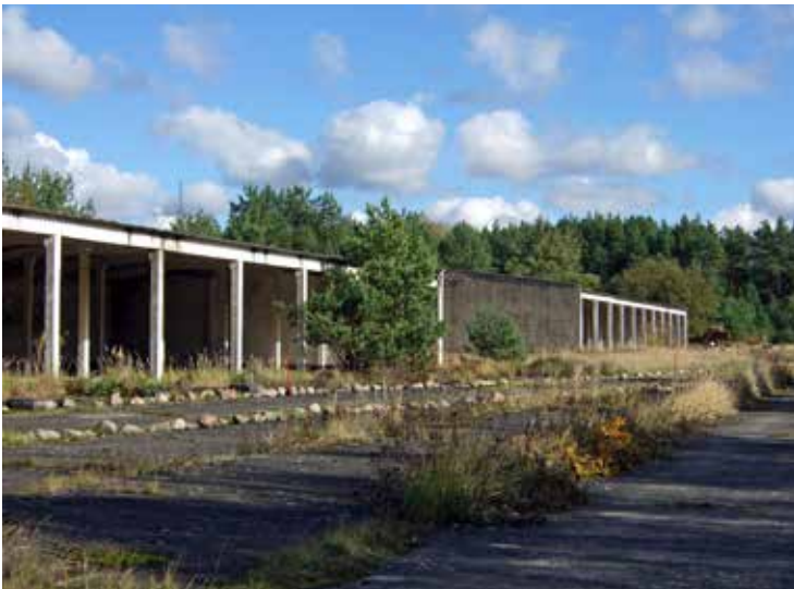
Markierung der Lagerstraße vor der Konversion
